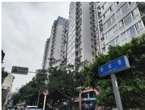
项目所在小区
